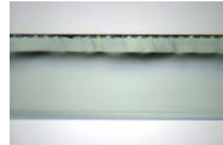
切割断面实拍
